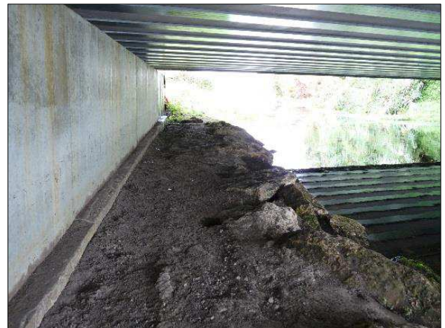
Banquette sous voirie empruntée par la Loutre
