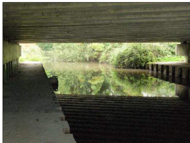
Ouvrage favorable à la circulation de la faune, banquette sous voirie en bordure de la jalle.
